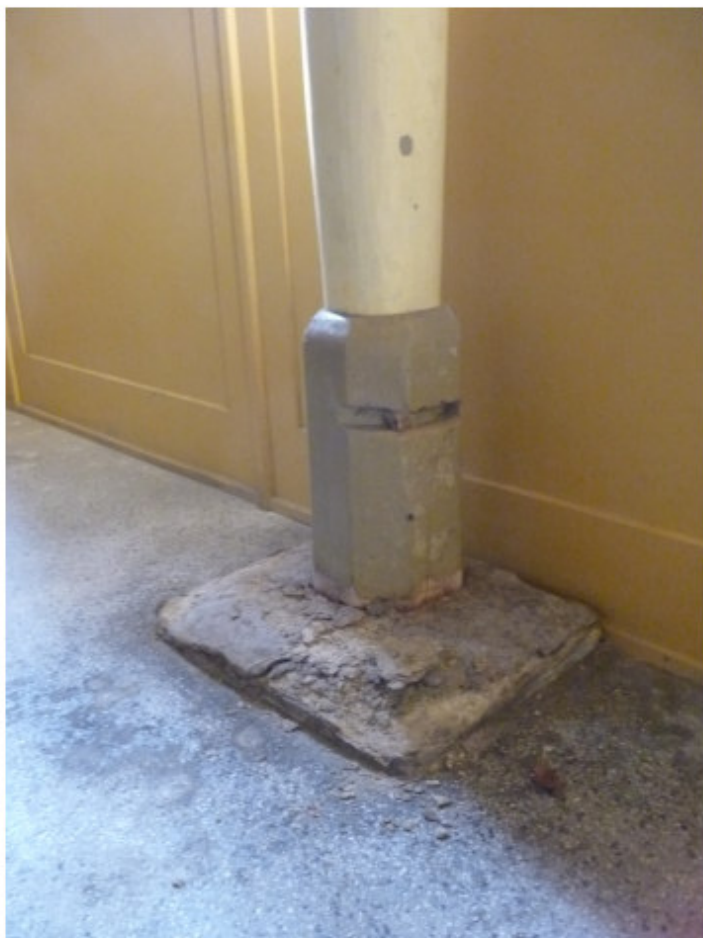
13_patka a sokl sloupu.jpg
