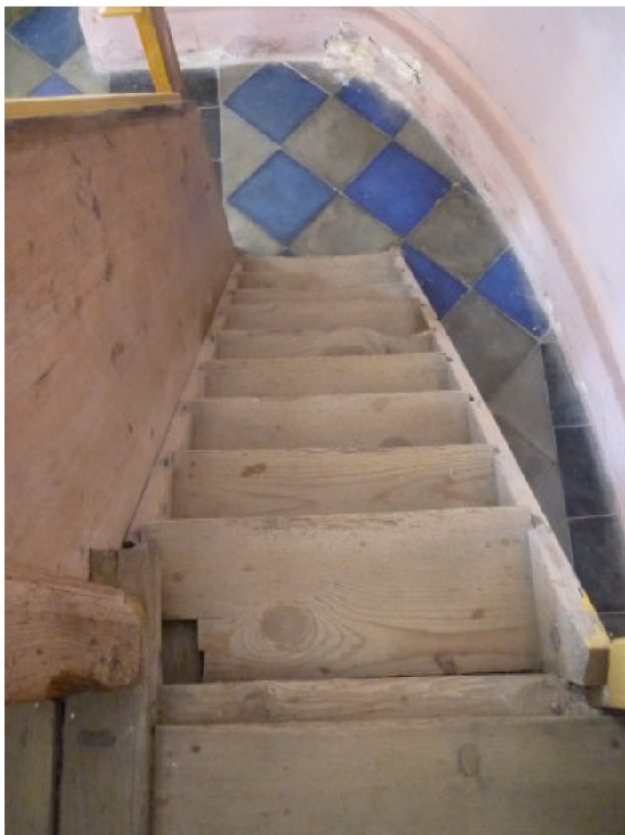
17_schodiště na kazatelnu.jpg
