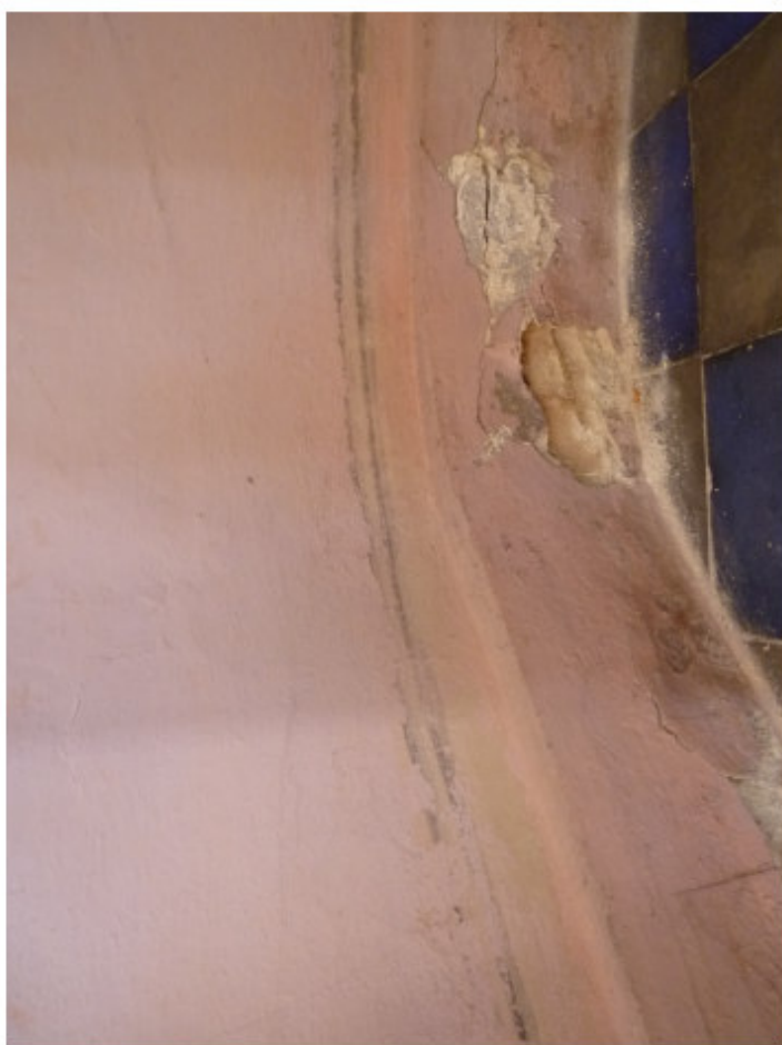
11_línková výmalba stěn.jpg
